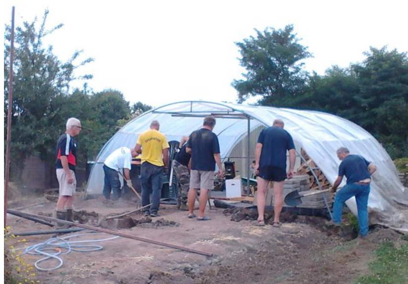
Les travaux ont commencé en août par la démolition de la moitié de l'ancienne serre. DOCUMENT REMIS
